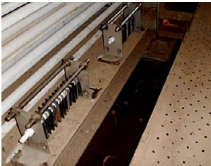
GGH reheater부 부식 시험편 설치
