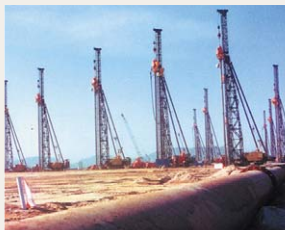
모래바람을 헤쳐가며 진행된 건설 현장의 파일함타 장면
