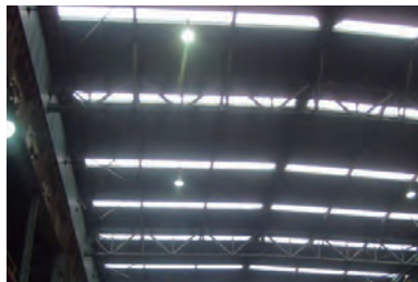
자연채광창을 설치하기 전 80 Lx의 밝기가 설치 후 500 Lx로 밝아진 모습 (주간 기준)
