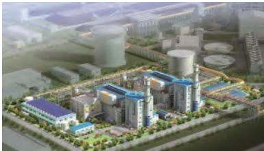
포항 부생가스 복합발전
