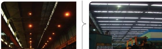
자연채광창을 설치하기 전 80lx의 밝기가 설치 후 500lx로 밝아진 모습(주간 기준)
