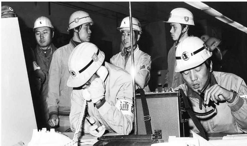
정용희 전 상무는 1978년 10월경 준공을 앞두고 있던 포항 2제강공장에 다량의 산소를 배관에 최초로 흘러 보내는 통산(通酸) 작업을 총괄 수행했다. 가운데 안테나가 서있는 기기가 무전기이다. 앞줄 왼쪽부터 통산 작업을 수행 중인 홍상복 공장장과 정용희 부공장장.
